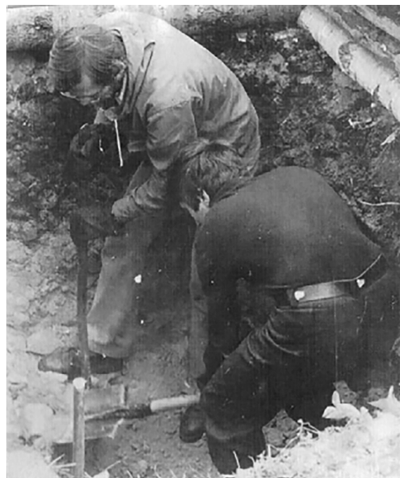
Начальник экспедиции В.Ф. Синьков и лаборант Г.Н. Вантеев готовят «блиндаж» для установки обсерватории ИЗМИРАН-4. Необходимость установки магнитометров в такие укрытия связана со стремлением избежать больших колебаний температуры на магнитах-индикаторах
